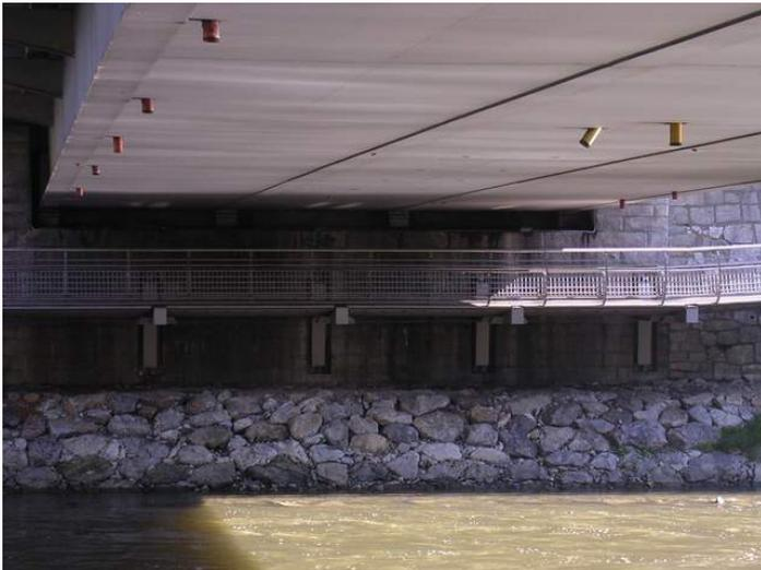
Da **nach der Unterquerung der Keplerbrücke** das dortige Gelände wesentlich niedriger ist, **wurde ein Betonbauwerk errichtet**, welches den Übergang von der Rad- und Gehwegunterführung zum bestehenden Geh- und Radweg am Schwimmschulkai herstellt.
